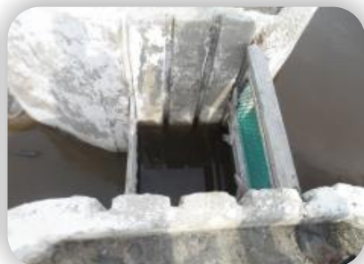
Compuertas de entrada de agua con sellos de madera
