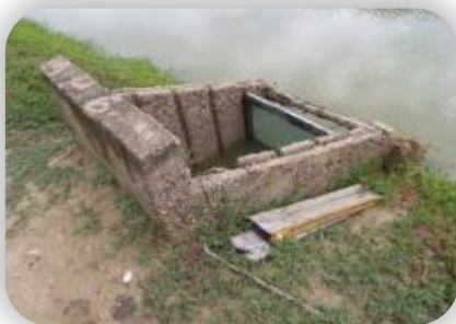
Compuertas de entrada de agua con sellos de madera
